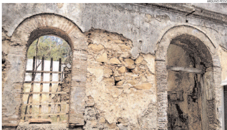
As ruínas de presídios e antigas construções estão entre os cenários de Presos no paraíso
